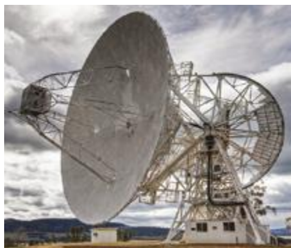
Apparecchiature di telecomunicazione e sistemi di controllo Telecommunications equipment and control systems
