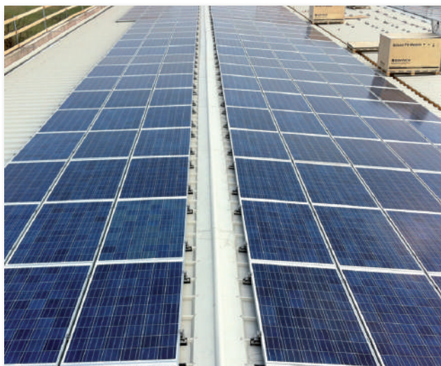
Tetto in lamiera grecata grecata. Installazione con staffa universale FVT5000 e guarnizione butilica FVT1552.
