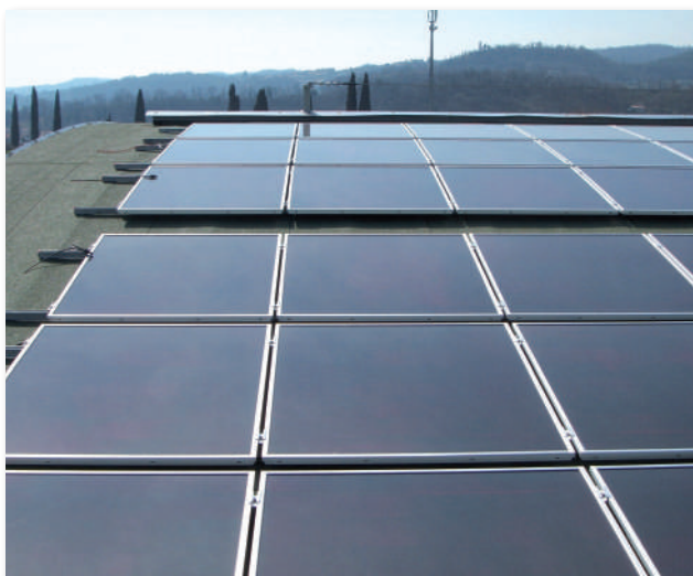
Tetto guaina industriale a volta. Applicazione diretta PRF zincato a caldo con guarnizione butilica.
