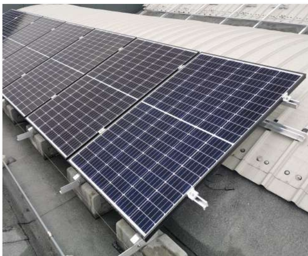
Impianto su cupolini con fissaggio misto: su lamiera grecata con profilo a base larga e su zavorre.
