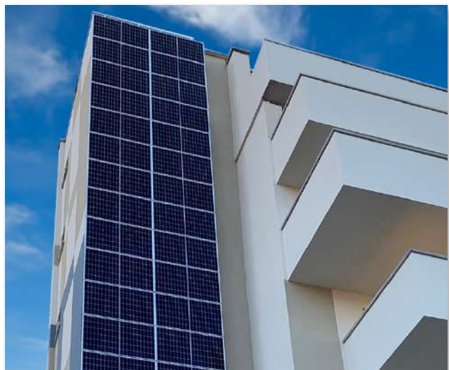
Pannelli in orizzontale in facciata.
