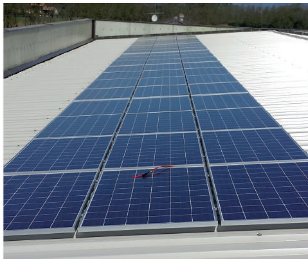
Impianto su lamiera grecata con pannelli in orizzontale fissati sul lato lungo. Applicazione con staffe universali FVT5000.
