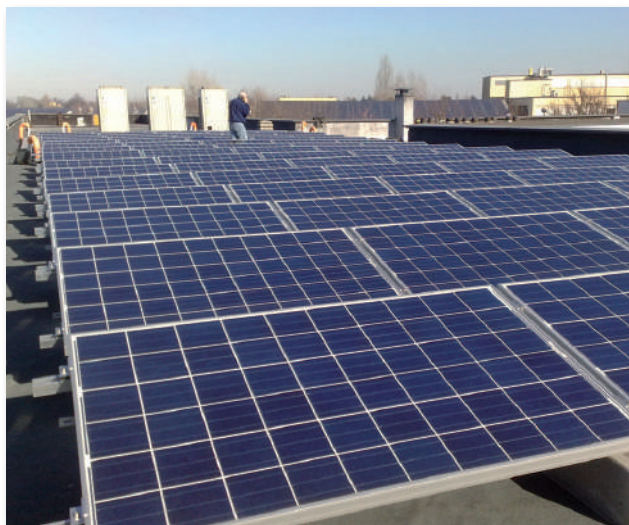
Tetto piano con triangolo singolo orizzontale zavorrato.
