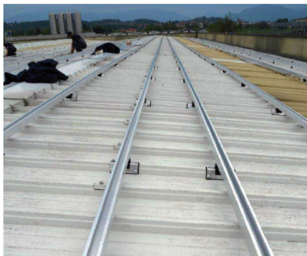
Tetto in lamiera grecata. Applicazione con staffe a disegno FVT95XX.
