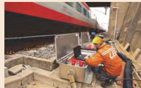
Installazione armadi di piazzale Un tecnico LEF durante l'installazione di un ADP su una linea AV per il riscaldamento elettrico deviatori
