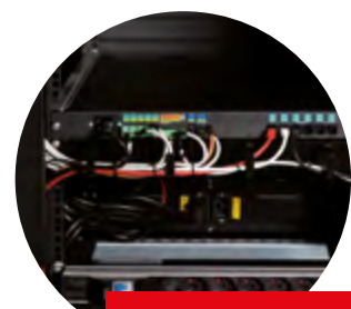
Prese di alimentazione sull'UPS
